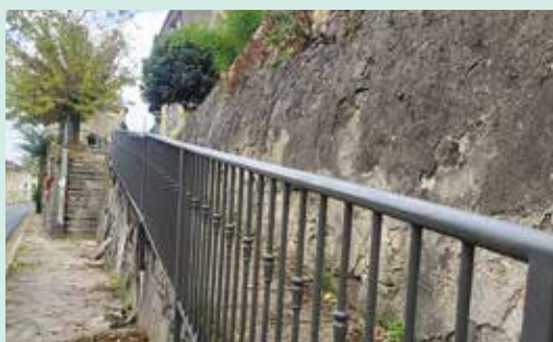
La nouvelle rembarde sur le chemin des escaliers. Des travaux entrepris mi-octobre pour sécuriser et embellir cette montée piétonne.
