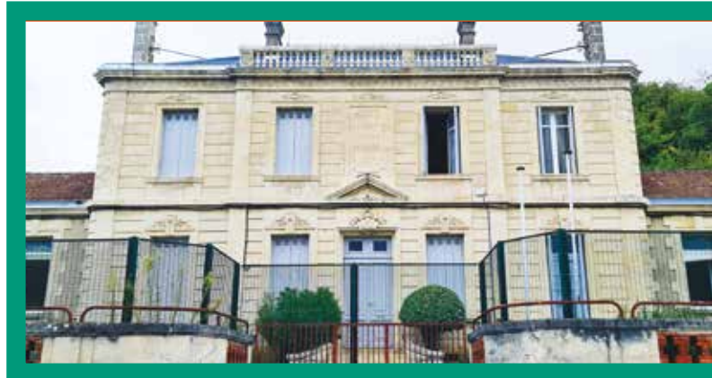
La façade du bâtiment et ses cheminées nettoyées.
